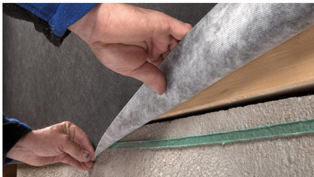
**7. Alternativ: Anschluss an raue oder mineralische Untergründe (z. B. Bodenplatte) mit ORCON MULTIBOND**
