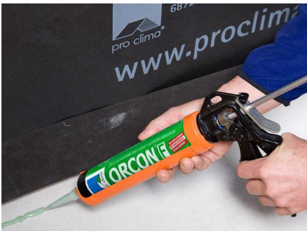
**6a. Anschluss an raue oder mineralische Untergründe (z. B. Bodenplatte)**
